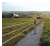
Cables para protección vial
