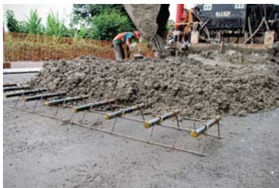
Colocación de Dowel en pavimento
